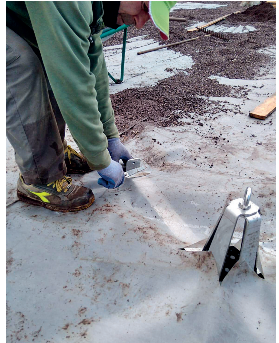
Posizionamento struttura MediSave.
